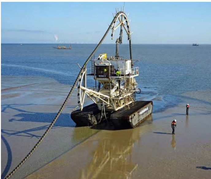
De wadtrencher (bron: TenneT)
