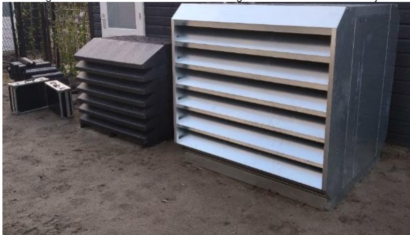
Afbeelding 3.6 Voorbeeld van akoestische omkasting van een buitenunit horend bij een lucht-wp (bron: Peutz)
